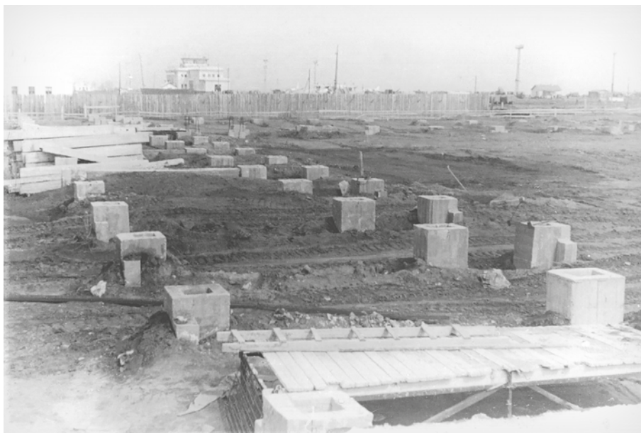
Фото 2. Строительная площадка ангарного корпуса линейно-ремонтных мастерских (ЛЭРМ). Фундаменты 6 . РГА в г. Самаре. Ф. Р-244. Оп. 4-1. Д. 80. Л. 199
