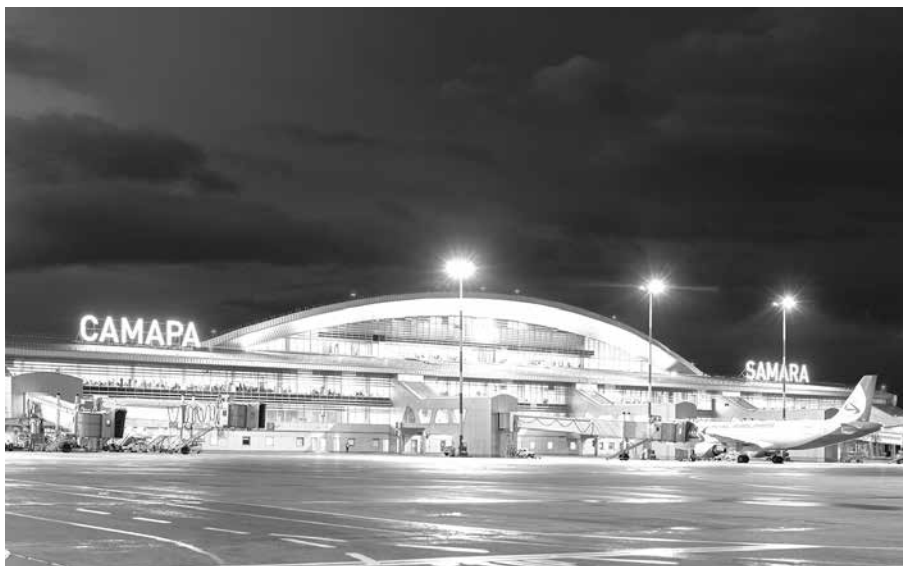
Фото 9. Вид с перрона на современный аэровокзал [10]
