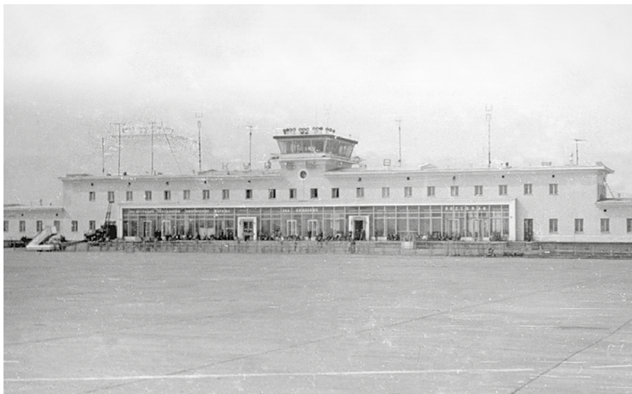
Фото 4. Фасад аэровокзала со стороны летного поля. РГА в г. Самаре. Ф. Р-244. Оп. 4-1. Д. 80. Л. 108
