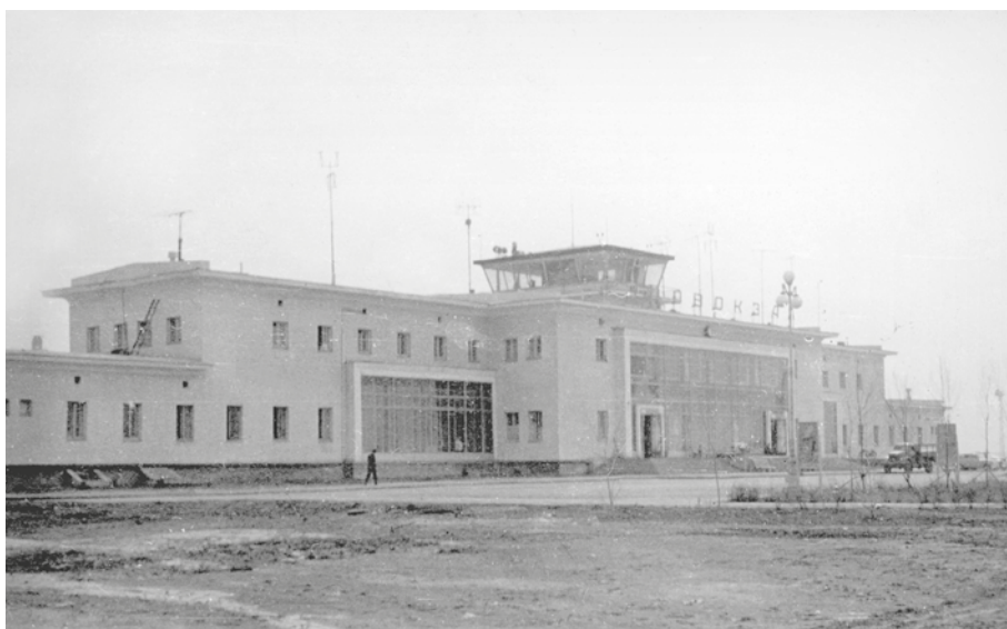
Фото 5. Фасад аэровокзала в Курумоче со стороны привокзальной площади. РГА в г. Самаре. Ф. Р-244. Оп. 4-1. Д. 80. Л. 108
